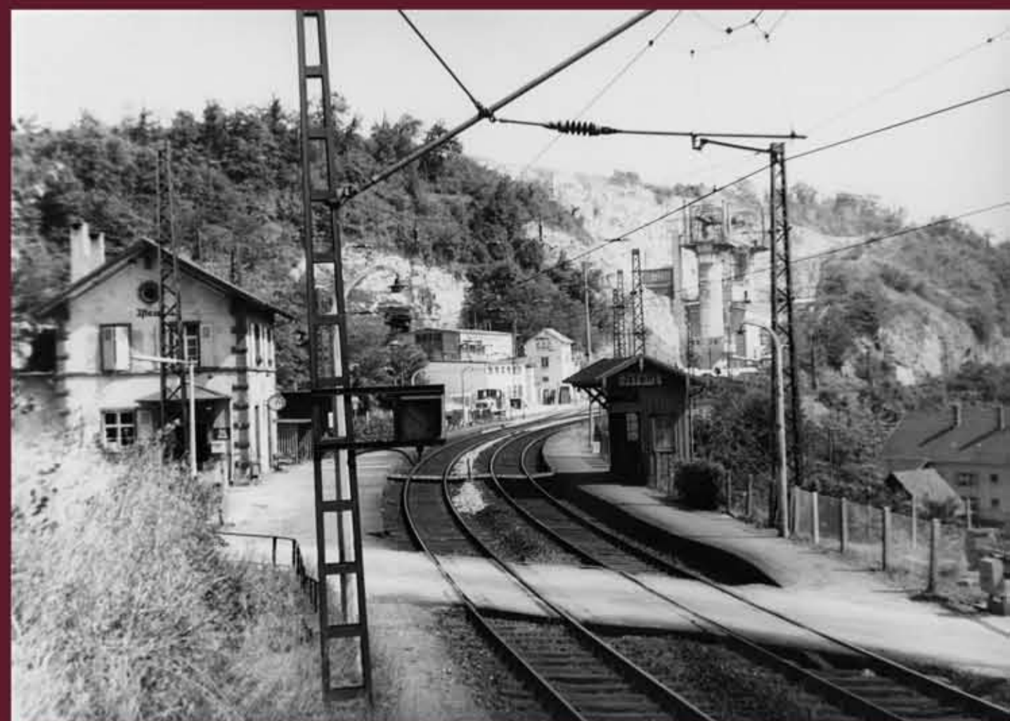
Bahnhof in den 60er Jahren
