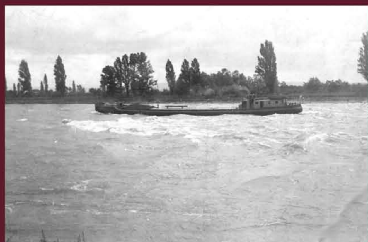
Isteiner Schwellen vor dem Kanalbau
