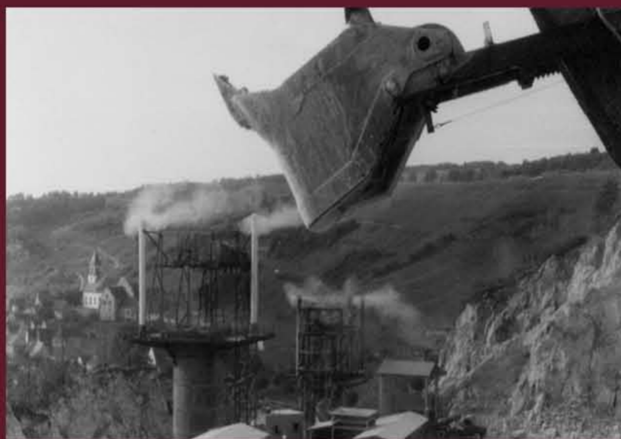
Öfen in Betrieb
