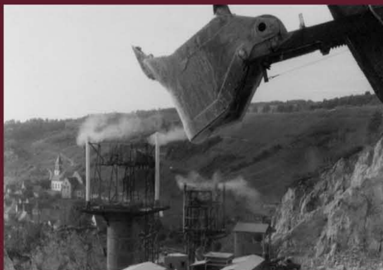
Öfen in Betrieb
