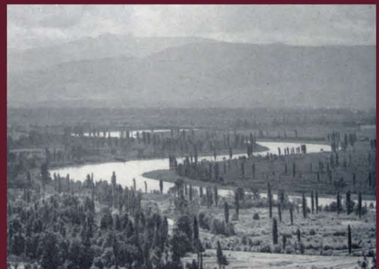
Der Rhein nach Konektion, aber vor Kanalbau (um 1920)
