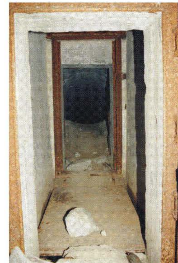
Falltüre mit abgesenkter Fallgrubenabdeckung
