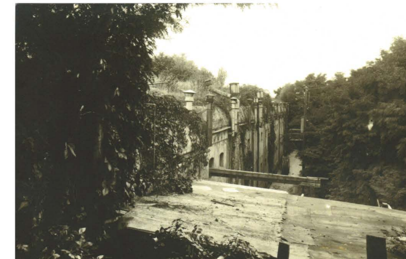
Infanteriewerk mit angebauter Flankierungsanlage im Vordergrund
