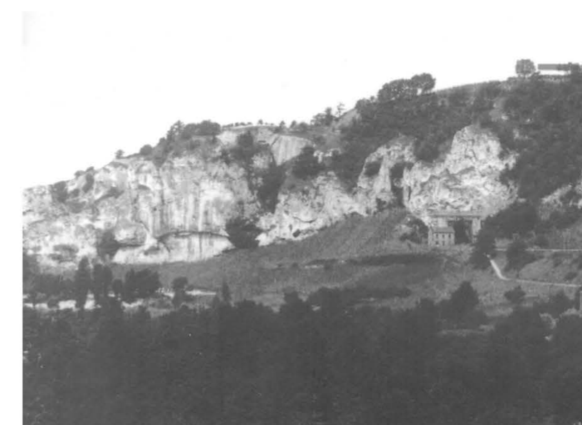
Infanterieraum 7 auf dem Felssporn, dem Gelände perfekt angepaßt
