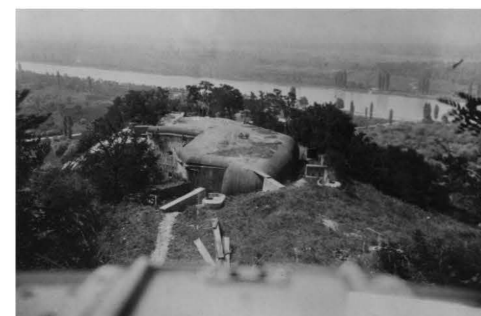
Blick auf Infanterieraum 7 und Rhein. Im Vordergrund sind Betonschulterwehren und Schneckenbeobachter erkennbar.
