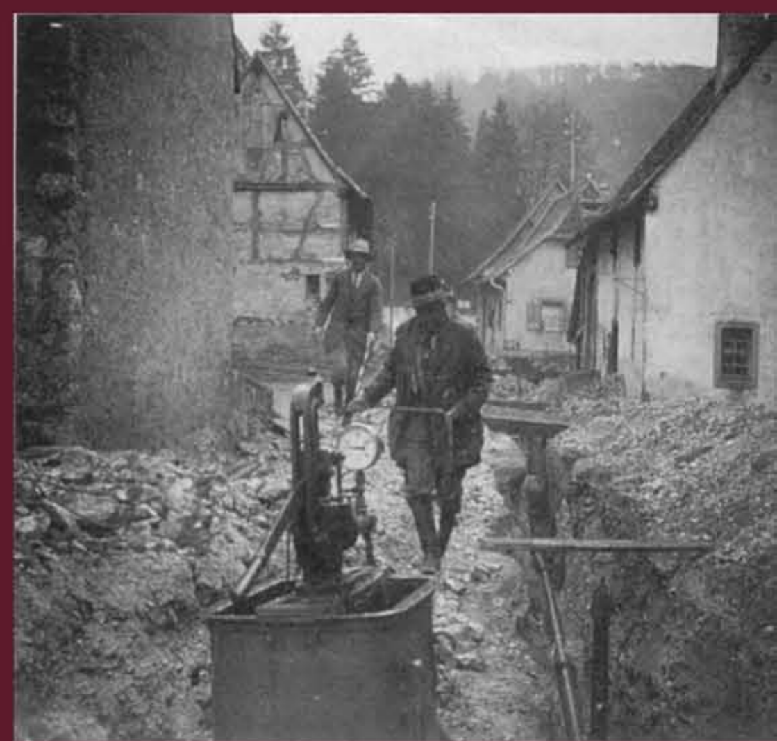
Bau der Wasserleitung 1932
